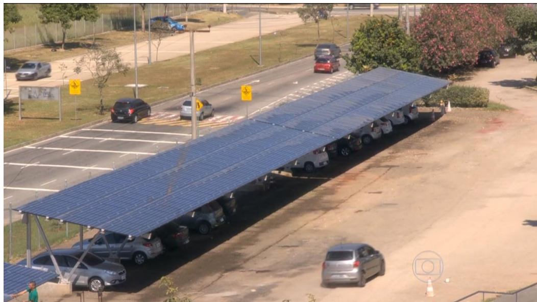
Figura 20: Estacionamento com painel solar na UFRJ
